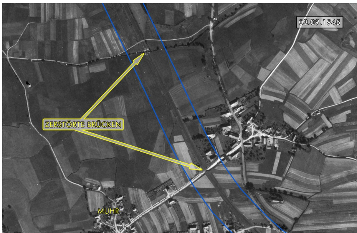
Abb. 2: Zwei der drei zerstörten Brücken (km 30,14 & 30,62) am 03.09.1945 (Flug-Nr. 104W-LIB-131, #3085-3091, Ausgangsmaßstab ca. 1 : 15.000).
